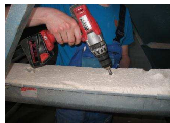
Снятие экрана с прямошовной трубы с помощью аккумуляторной дрели
